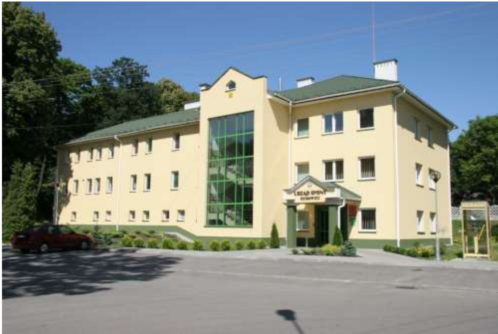
Fot. Budynek Urzędu Gminy Dzikowiec
